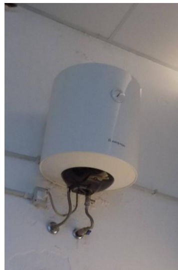
Figura 4.15 - Particolare della caldaia murale per la produzione di ACS in cucina
