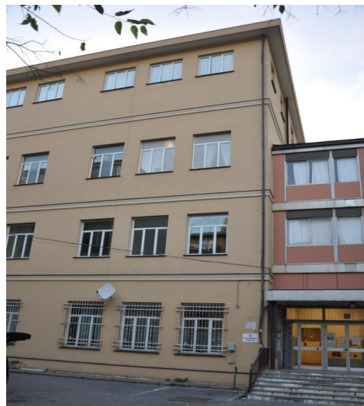
Figura 1.1 - Vista della facciata est nel punto di raccordo tra edificio scuola primaria ed edificio scuola secondaria di I grado e materna
