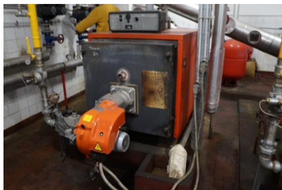
Figura 4.13 - Particolare di un generatore di calore
