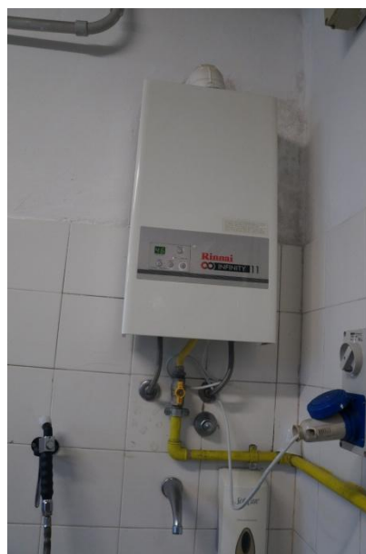
Figura 4.15 - Particolare della caldaia murale per la produzione di ACS in cucina
