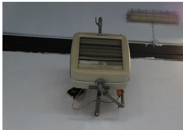
Figura 4.7 – Particolare di un aerotermo installato in palestra
