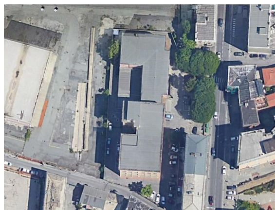
Figura 2.2 - Vista satellitare dell'edificio (Fonte: Google Earth)
